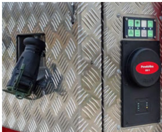
Abbildung 34: Stromeinspeisung PowAirBox, alternatives Bedienteil inomatic®.
