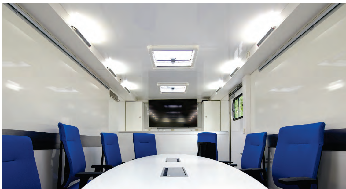
Abbildung 51: Kombinierte Luftführungskanäle im Dachbereich, hier sind auch die Lichtelemente der indirekten Beleuchtung montiert. Weiterhin dient der Kanal ggf. als Kabelkanal für Strom und EDV. Durch diese Bauweise sind nachträgliche Erweiterungen problemlos möglich.
