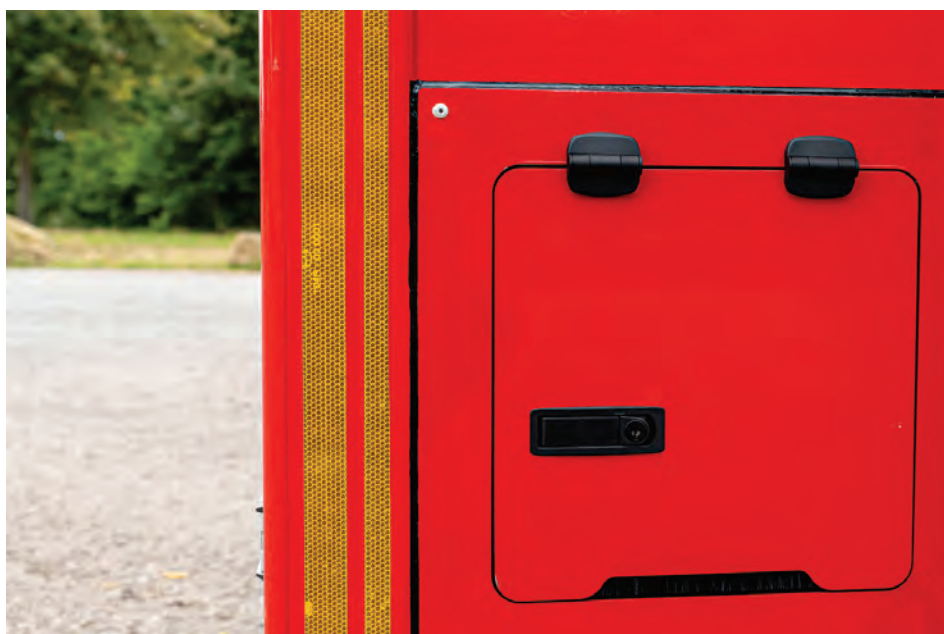
Abbildung 29: Detail – Verschlussklappe der Übergabeeinheit, abschließbar mit Borstendichtung im unteren Bereich für die geschützte Kabeldurchführung.
