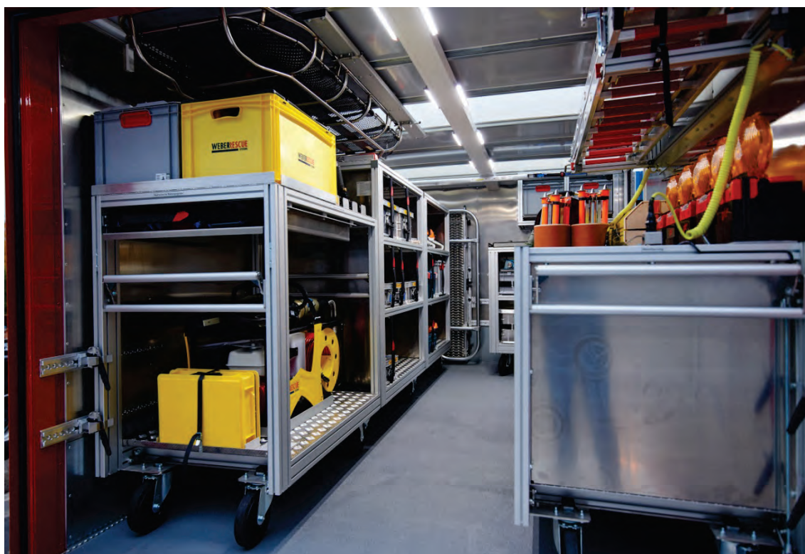
Abbildung 6: Anordnung MEINDL-Rollcontainer im GW-L verlastet. Hier in U-Anordnung mit Mittelgang, dadurch ist die Beladung aller Rollcontainer zugänglich.
