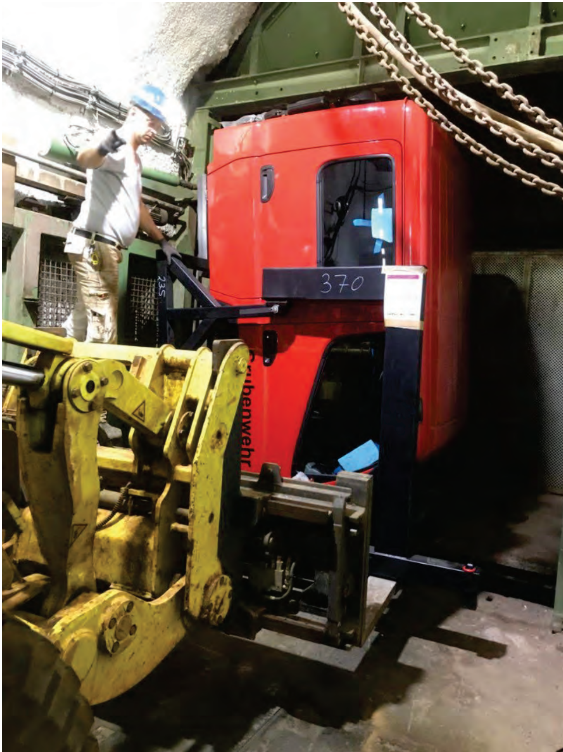
Abbildung 9: Fahrstuhl-Transport des Segmentes „Fahrerhaus“. Eine spezielle MEINDL-Schwenkvorrichtung erlaubt den Transport im Fahrstuhl in senkrechter Stellung und den Weitertransport in waagerechter Stellung (wegen der geringen Tunnelhöhe).
