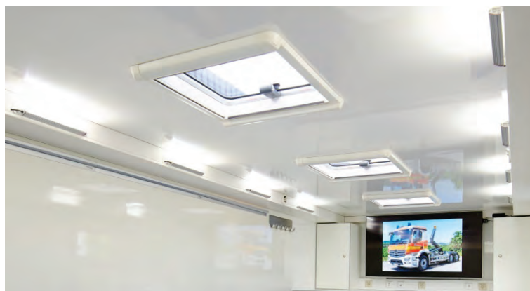
Abbildung 50: Blendfreie Beleuchtung durch indirektes Licht.
