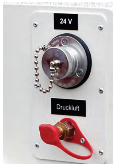
Abbildung 70: Energieeinspeisung 24 V und Druckluft (einfache Ausführung).
