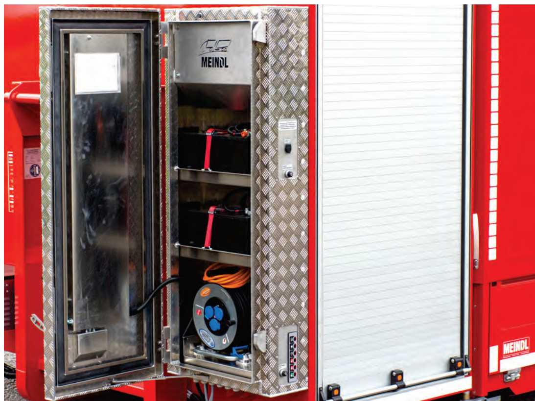
Abbildung 23: Detail – Zentraler Stirn-Schaltschrank, sehr hochwertige Ausführung mit 2 Verschlüssen und groß dimensionierter Gummidichtung. Der MEINDL-Schaltschrank ist von uns speziell für diesen Einsatzzweck konstruiert!
