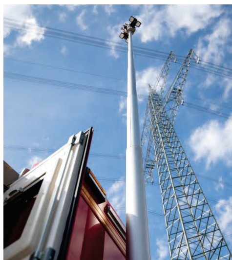
Abbildung 54: Antennenmast, hier kombiniert als Lichtmast.
